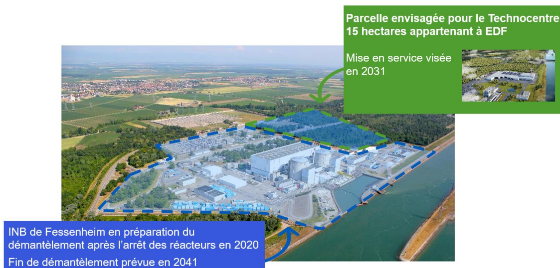
Localisation de l'Installation nucléaire de base (INB) en préparation au démantèlement (encadrée en bleu) et de la parcelle envisagée pour le Technocentre (encadrée en vert)
