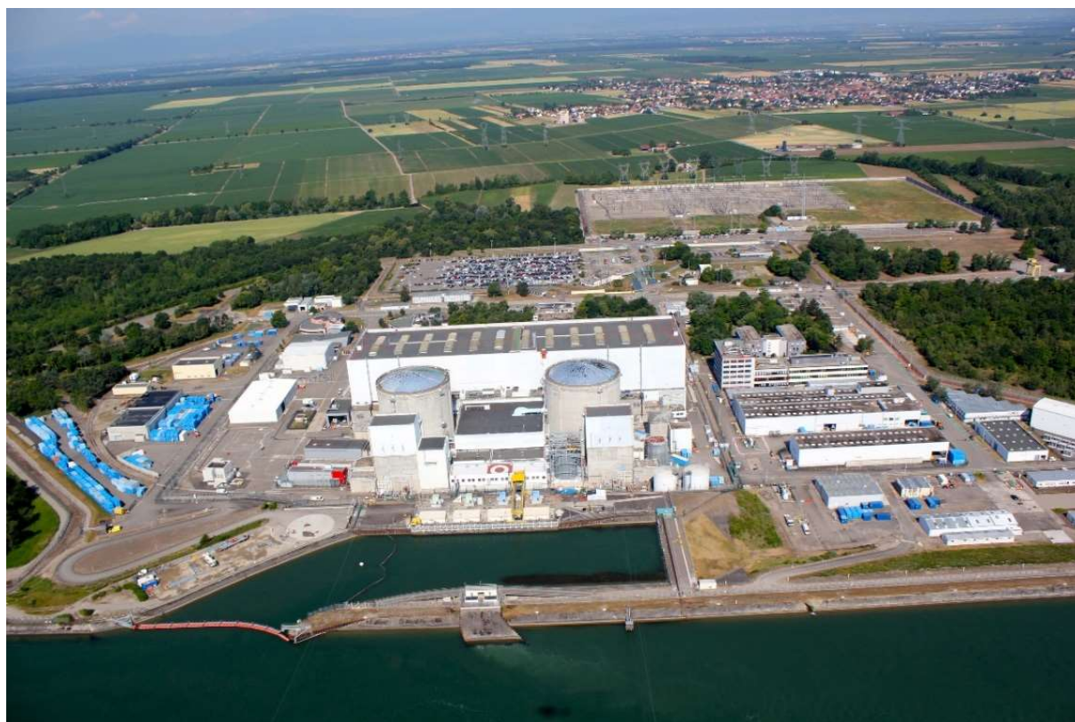
Vue d'ensemble de la centrale de Fessenheim © EDF
