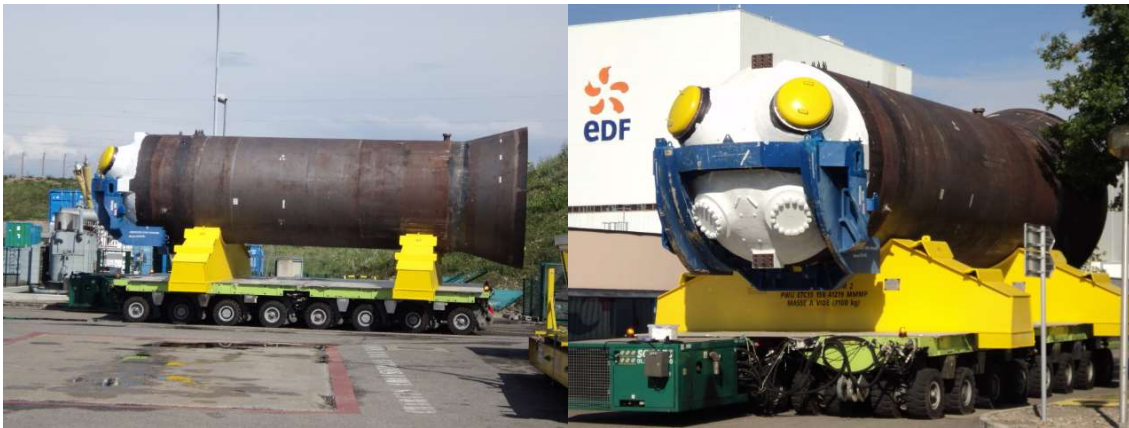
Figure 9.j Illustration d'une circulation d'un gros composant – Opération de remplacement des Générateurs de Vapeurs – CNPE de Fessenheim 2011
