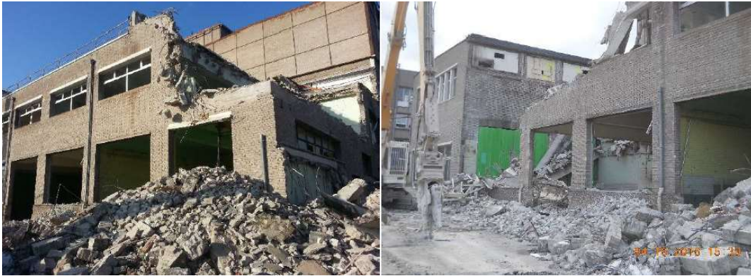
Figure 9.k Illustration d'une phase de démolition – Opérations de déconstruction de bâtiments administratifs et ateliers de la centrale thermique de Richemont
