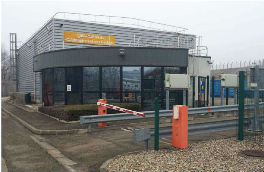
Figure 10.i. Entrée du Centre de Regroupement des Déchets © EDF
