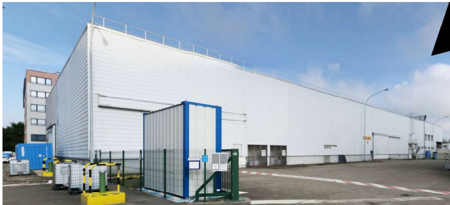
Figure 6.2.8.2.a Bâtiment d'entretien de site (BES)
