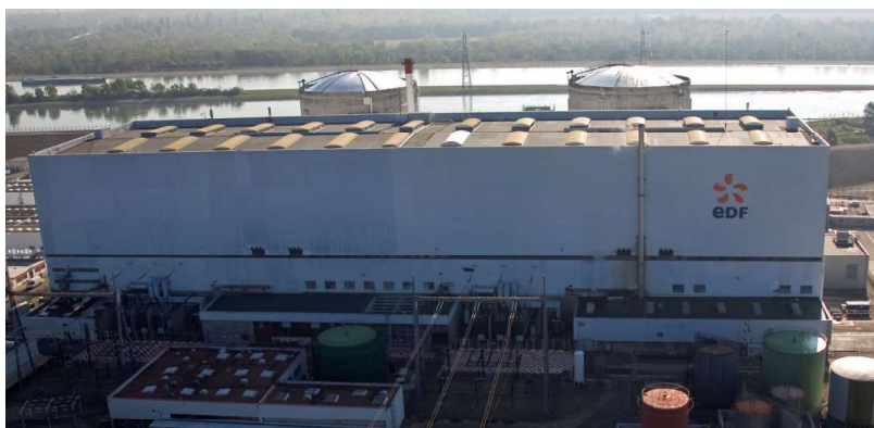
Figure 6.2.5.2.a Bâtiment « Salle des machines » – IDT TFA FAMA et zone de transit MAVL
