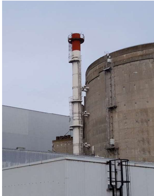
Figure 6.4.a Vue de la cheminée du BAN
