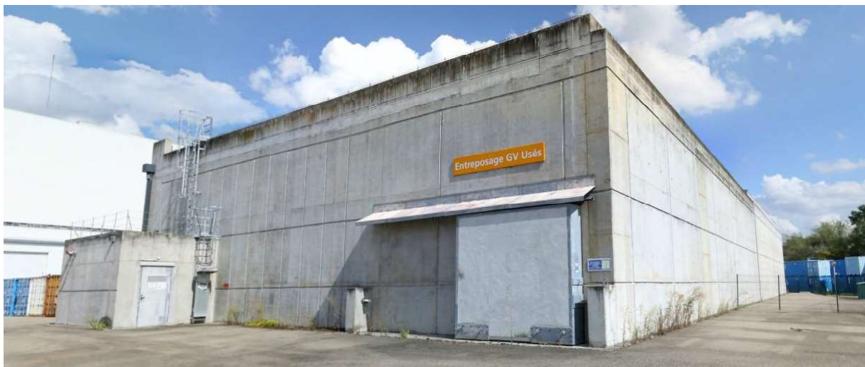
Figure 6.2.6.2.a Bâtiment d'entreposage des générateurs de vapeurs (BEGV 1 et 2)
