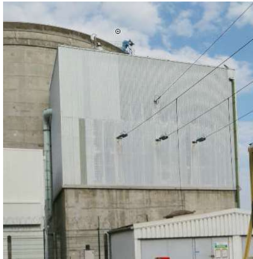
Figure 6.2.2.2.a Bâtiment combustible de l'unité 2
