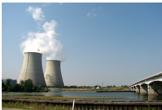
Centrale nucléaire de Belleville (Cher), en 2006. Wikimedia Commons/CC/Panelfestoon
