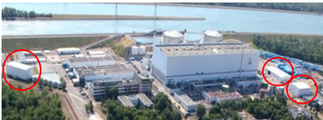
Centrale de Fessenheim – novembre 2020
